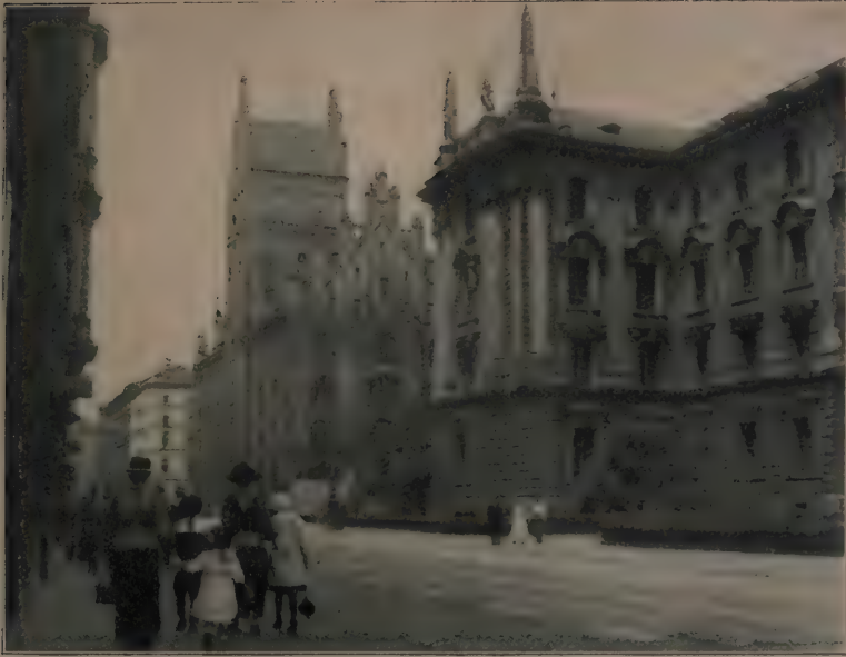
Abb. 101. Blick in die Prielmayerstraße im Münchner Bahnhofsviertel mit dem Justizpalast und dem neuen Justizgebäude. Unvermittelt sind hier Bauwerke der Hochrenaissance und eines polychromierten gotisierenden süddeutschen Barocks („Ulmünchner Stil“) in eine nüchterne Umgebung gesetzt, ein beredtes Zeichen großstädtischer Stilanarchie. (Vgl. dazu S. 308.) Original von Frau Dr. A. Friedrich-München.
